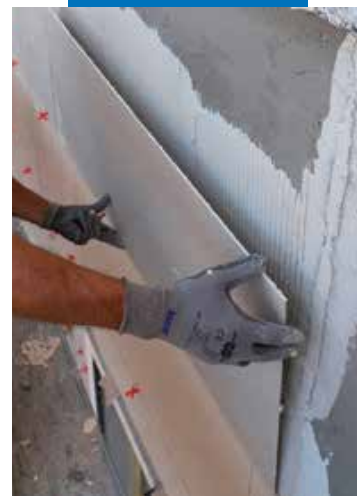
Montering av tunn platta av granitkeramik på en utvändig fasad
