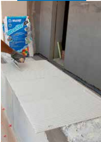
Applicering av fästmassa på baksidan av plattan
