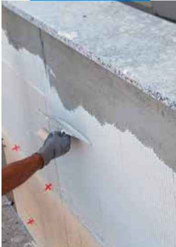
Sättning på utvändigt fasad: applicering av fästmassa på underlaget
