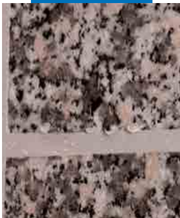
Fogning av utvändig stenbeklädning
