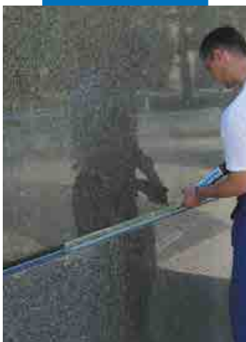
Fogning av fasad med Mapesil LM
