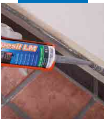
Fogning av invändig stenbeklädning
