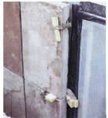
85. Under monteringen används gipskrokar och kilar för justering och inhållning.
