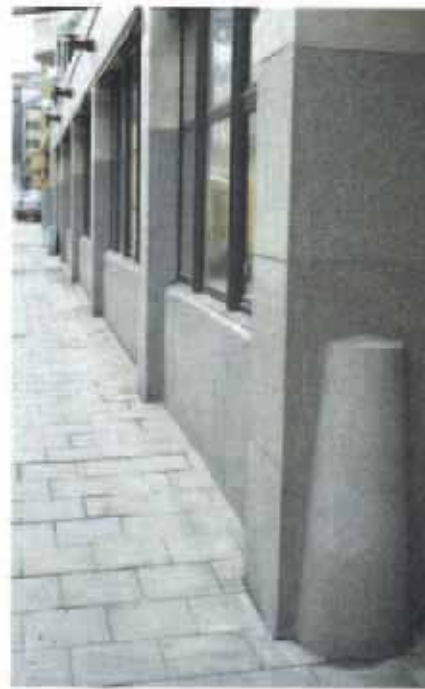
72. Pollare som integreras i sockeln utgör extra påkörningsskydd vid exempelvis garageinfarter.
