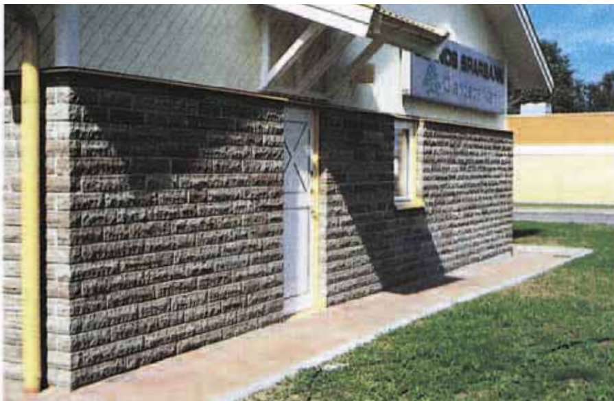
16. Skalmur av dubbelstucken kalksten.
