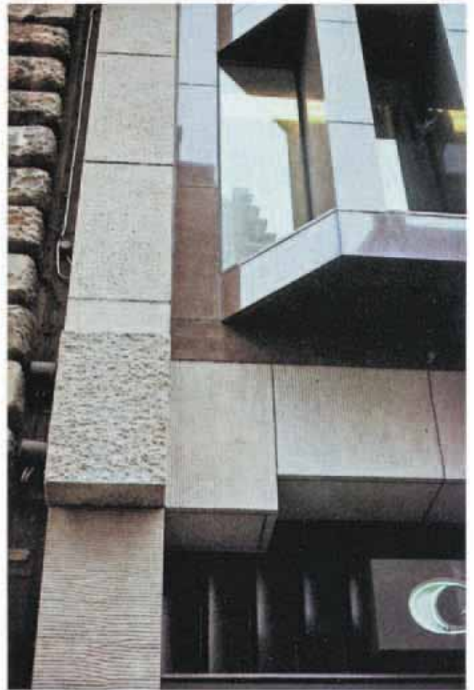
13. Polerad, krysshamrad, pikhuggen och räffelhamrad yta ger variationer i den röda graniten.
