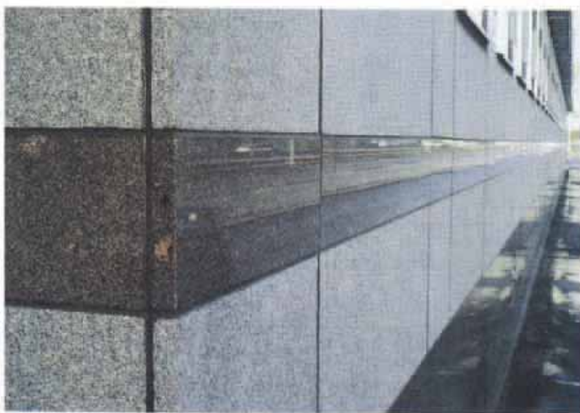
4. Modern, ventilerad fasadbeklädnad med fasadplattorna individuellt monterade med rostfria, syrafasta kramlor.
