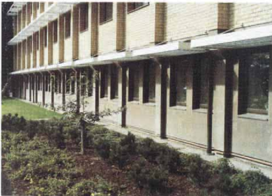
15. Finslipad, röd kalksten som bottenvåningsbeklädnad.
