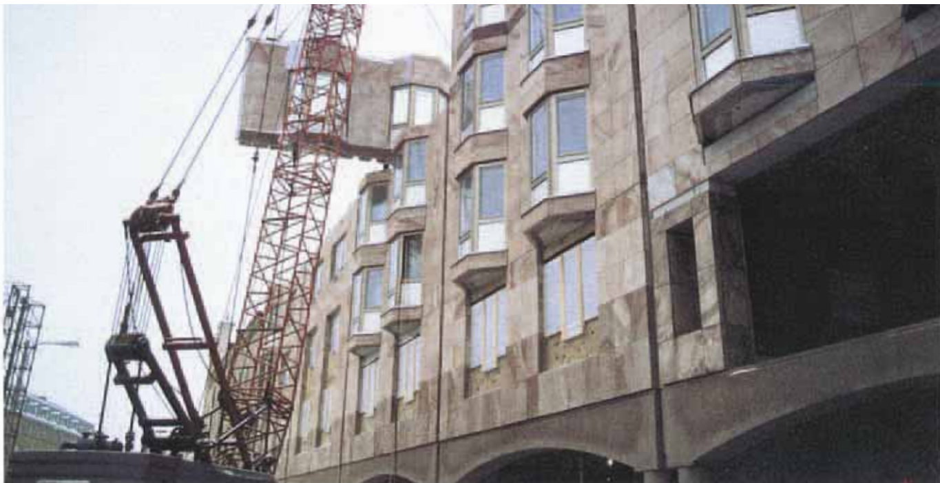
59. Montering av bärande betongelement typ 1:C, med fasadbeklädnad av kvartsit. Färdig byggnad, se sid 10.
