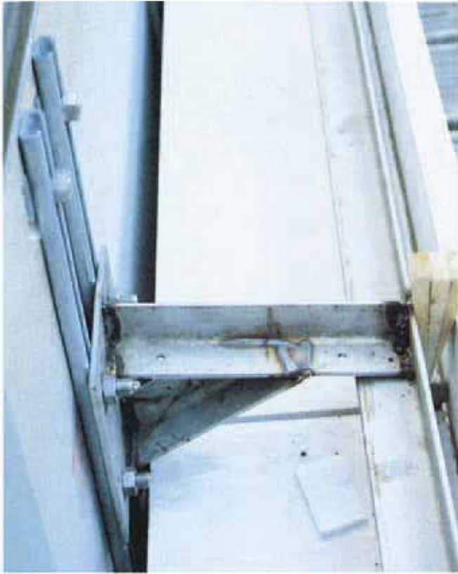
26. Konsol för montering av gesims, infästad i ankarskenor.
