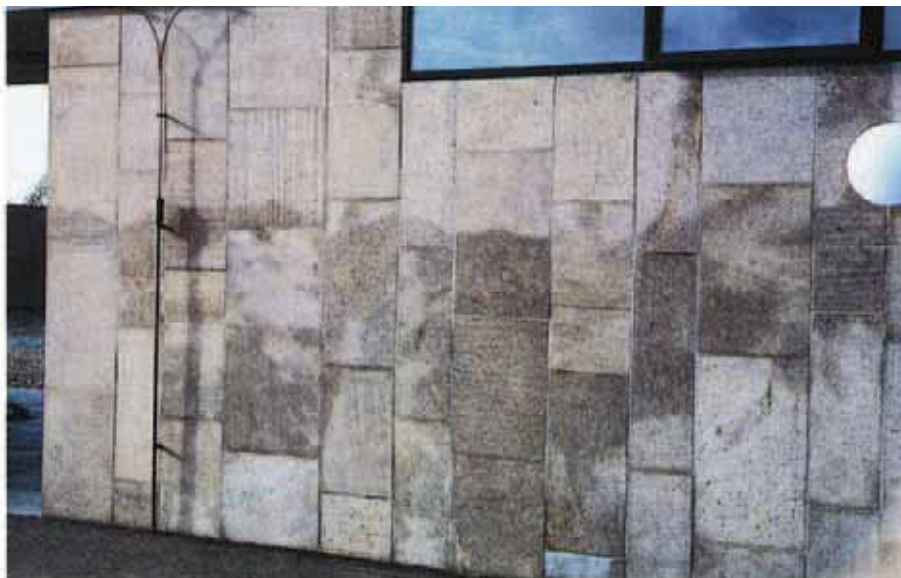
94. Bakgjutning med cementbruk kan orsaka misspyrdande fuktfläckar.
