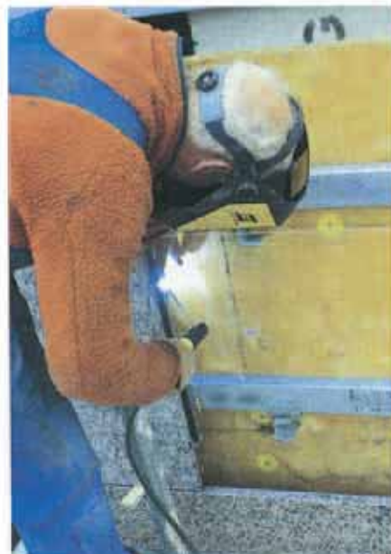
89. Svetsning av kramla mot bärverk.
