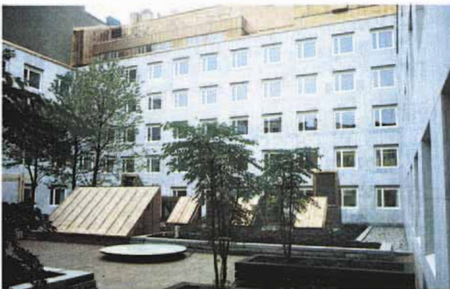
17. Slipad marmor som fasad mot planterad gård.
