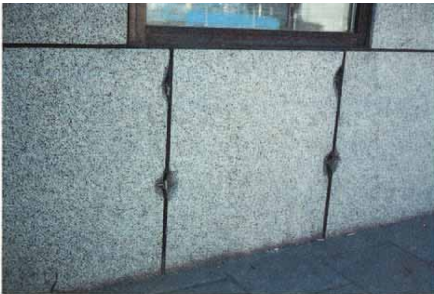
91. Om sockelplattor utsätts för alltför stort tryck kan dubbarna tryckas genom plattan.
