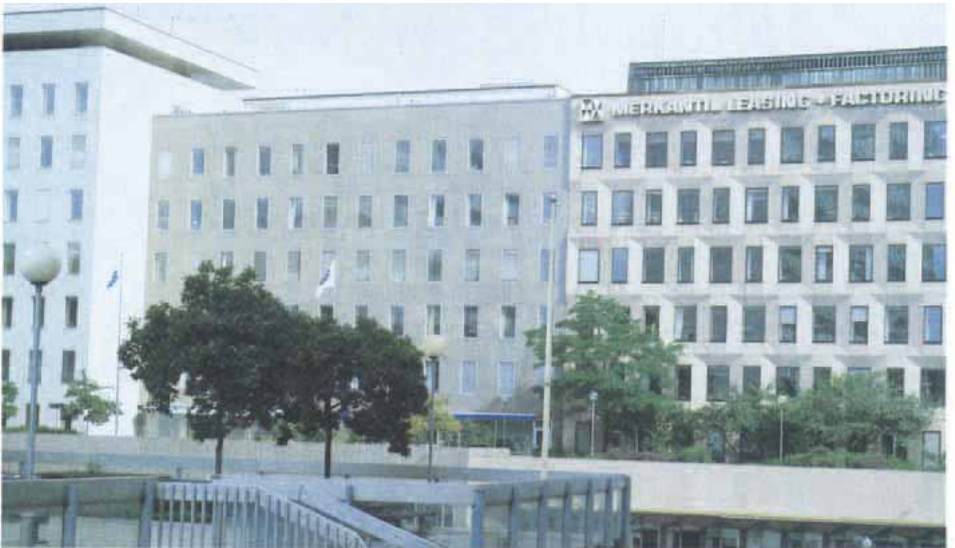
21. Granit har många uttrycksmöjligheter. Polerad, slät fasad kontrasterar mot kryschamram i fasettform.
