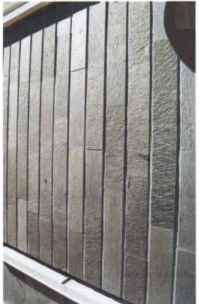
23. Smala remsor av skiffer med klovyta monterade i betong-element. Fogarna markeras genom nedfräsning av plattkanten.
