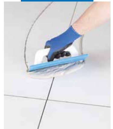
Applisering av Ultracolor Plus på marmor med gummispackel
