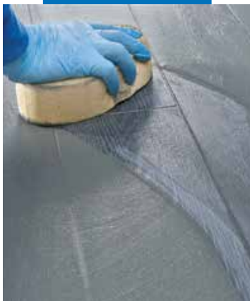
Rengöring och efterbehandling av kakelfogar med hård cellulosesvamp
