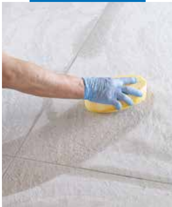
Rengöring av keramiska plattor på golv med Scotch-Brite®
