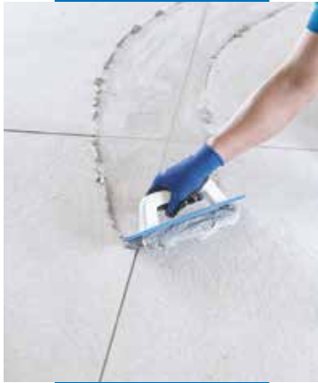
Fogning av plattor på golv med fogbrätt
