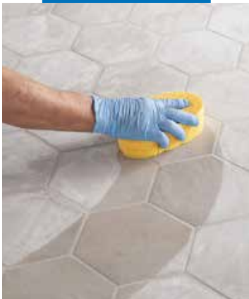
Avtvättning och justering av fogar med en hård cellulosasvamp
