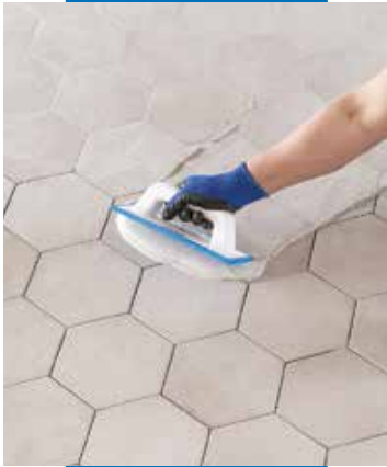
Fogning med Keracolor FF med fogbrätt
