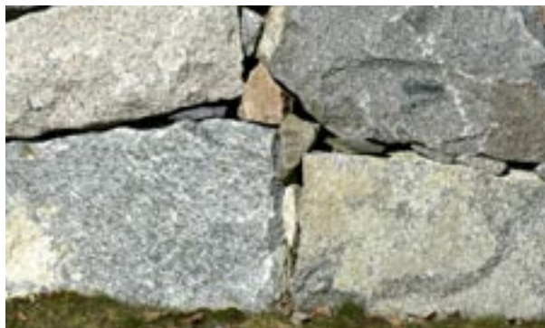
Fig 8.22 Mindre stenar, "skolsten" eller "lus" kilas in i stora fogar för att ge stabilitet.
