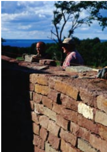
Fig 8.30 Montering av kalkstensskivor "flis" som kallmur.
