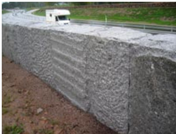
Fig 8.50 Missförstånd vid beställning från främmande land kan leda till leveranser som man inte har förväntat sig, i detta fall med mycket varierande ytbearbetning.
