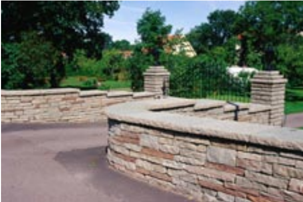
Fig 10.6 Grindstolpar och mur av kallmurad kalksten.
