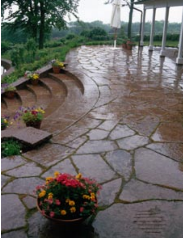
Fig 4.14 Altan med topphyvlad kalksten i oregelbundet mönster.
