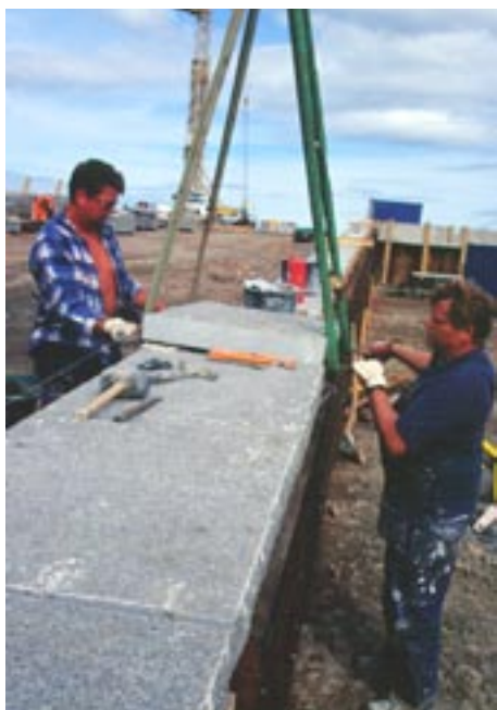
Fig 8.46 Granitavtäckning monteras
