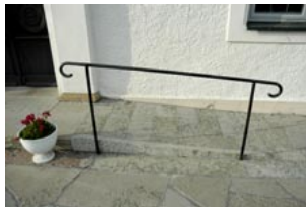
Fig 7.26 Låg ramp av kalksten för bättre tillgänglighet.
