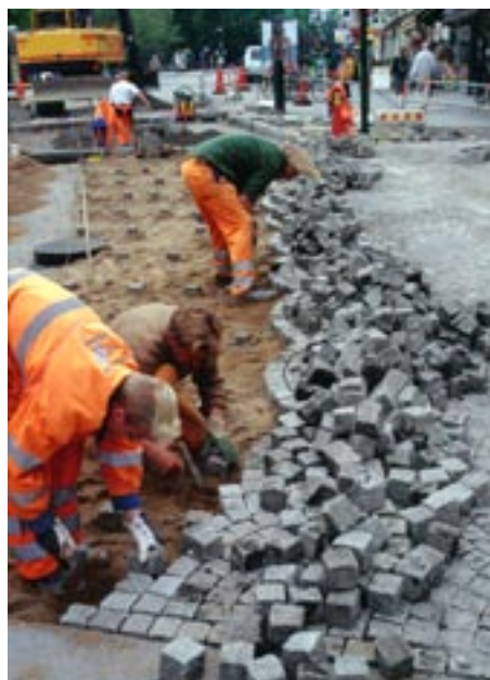
Fig 5.10 Bågsättning av smågatsten i sand
