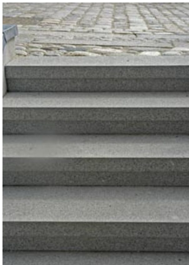
Fig 7.3 Beklädnadssteg av krysshämrad granit
