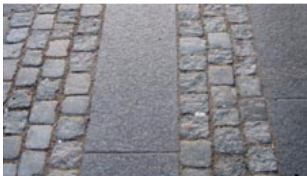
Fig 4.4 Granithäll med klippt kant mot gatstensbeläggning
