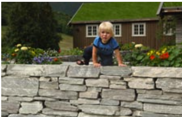
Fig 8.17 Kallmur av staplade skivor av skiffer
