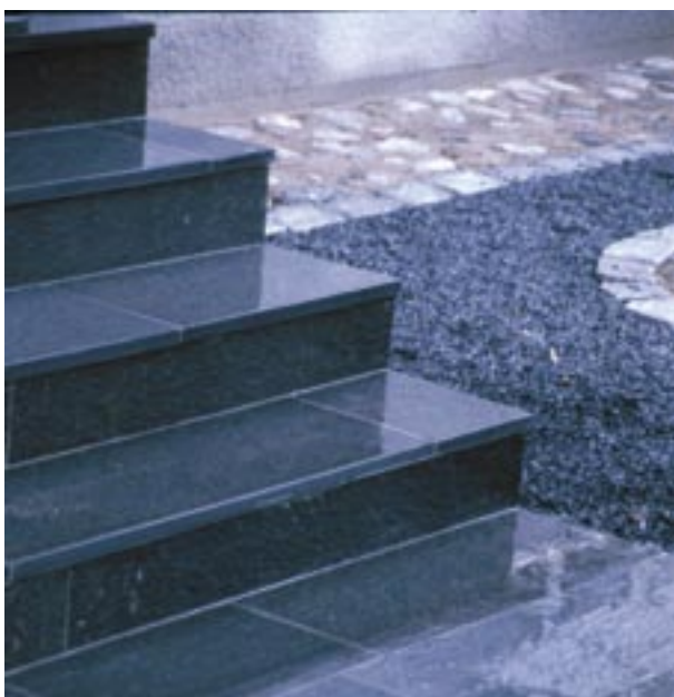
Fig 7.13 Beklädnadstrappa med steg av skiffer
