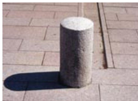
Fig 10.3 Cylindrisk, krysshamrad granitpollare. Rännstensplattor av flammad granit.
