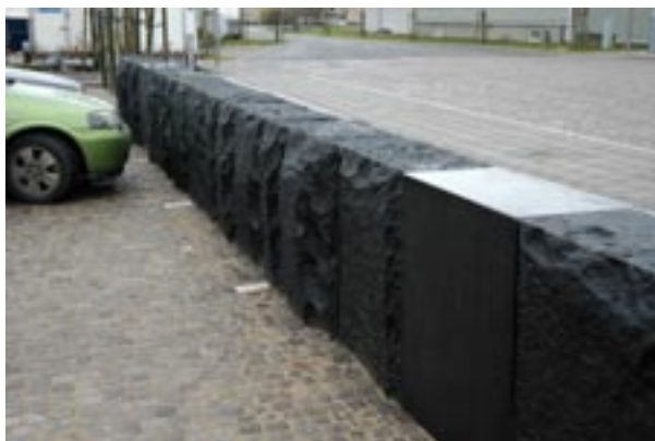
Fig 8.10 Blockstensmur av råkilade diabasblock med polerat block inlagt
