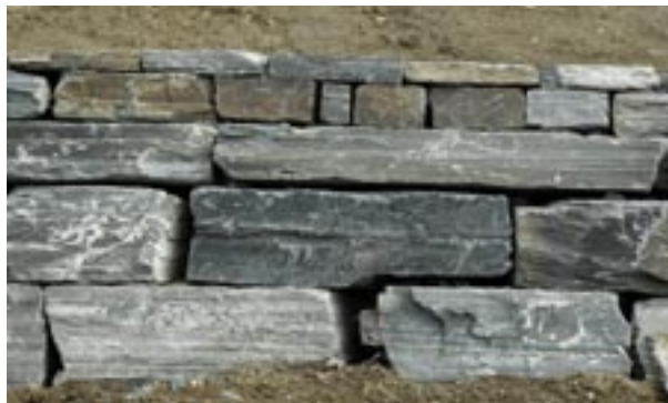
Fig 8.18 Kallmur av staplade skifferblock i kvaderförband.
