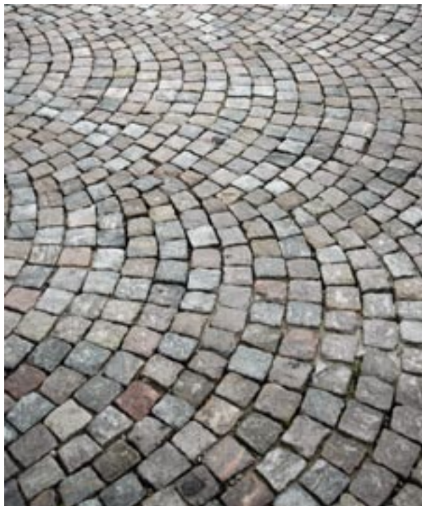
Fig 5.7 Bågsättning med smågatsten
