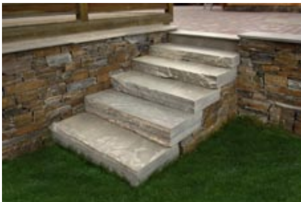
Fig 7.10 Blockstegstrappa av skiffer i anslutning till skifferkallmur.
