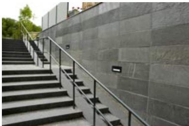
Fig 7.25 Barnvagnsramp integrerad i blockstegstrappa. Beklädnadsmur med skiffer.
