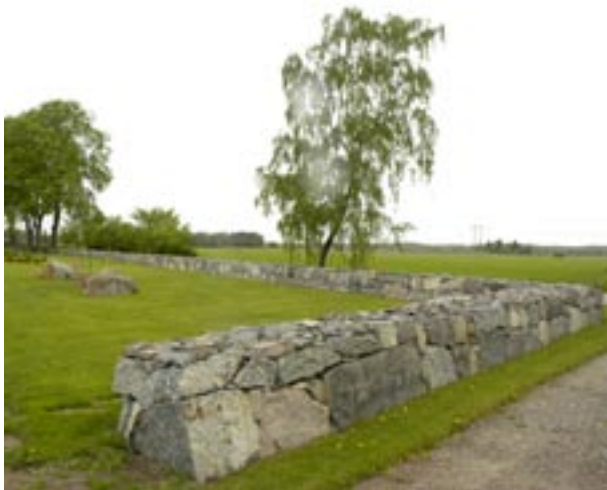
Fig 8.27 Kallmur av lokal sten, s k kyrkogårdsmur.
