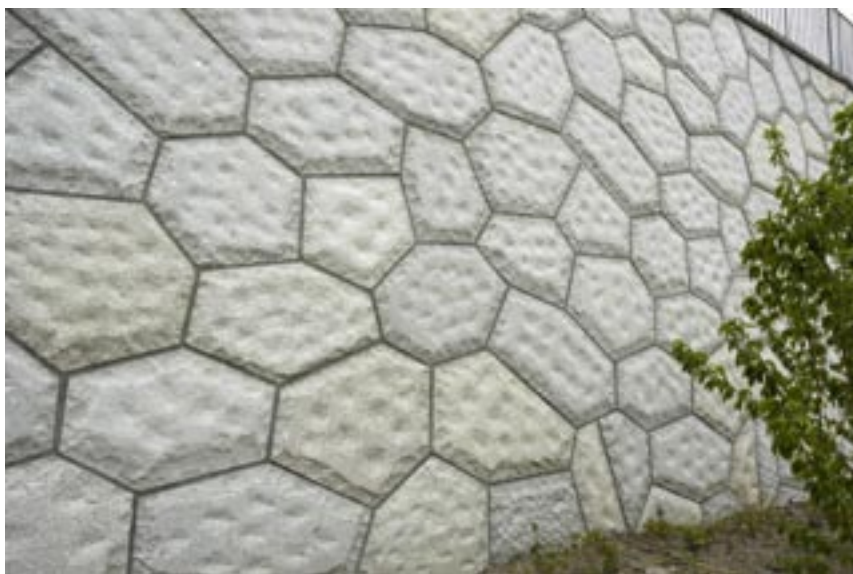
Fig 2.3 Leverans av polygonmur, tv, och blockmur, th, från fjärran land. Utseendet är inte vad beställaren hade förväntat sig, trots att stenen uppfyller alla krav enligt beskrivningen. Stenarna i polygonmönstret har en alltför jämn och enhetlig storlek. Ytbearbetningen ger i båda exemplen ett naturligt intryck.
