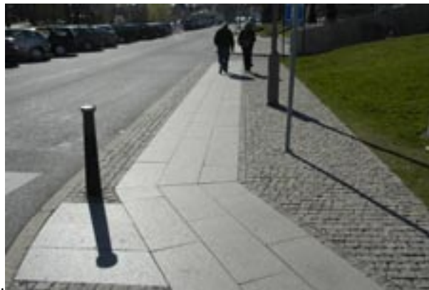
Fig 5.6 Rak stensättning med granithällar inlagda som gångyta.
