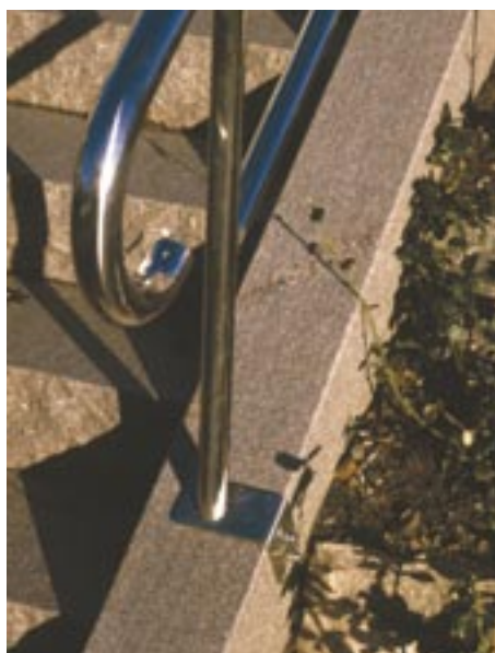
Fig 7.29 Infästning av rostfritt räcke i vangstycke av granit
