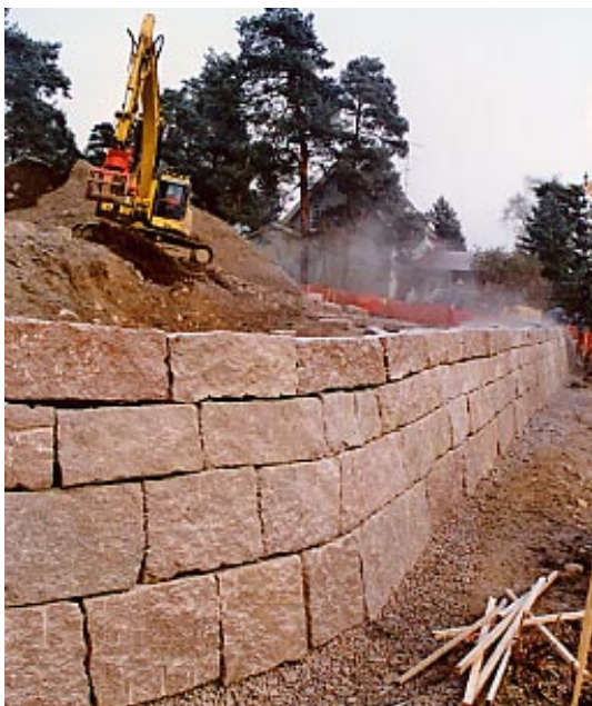
Fig 1.2 Kallmur av staplade råblock
