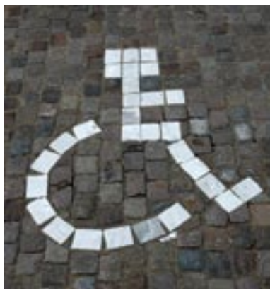
Fig 5.16 Gatsten med olika kulör kan användas för beständig markering i gatan.
