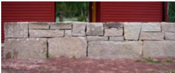
Fig 8.7 Kallmur av granitblock i rubbelförband
