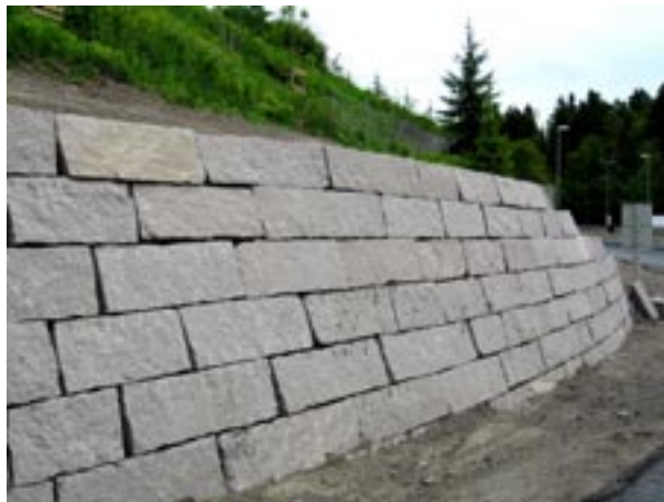
Fig 8.29 Kallmur av granitblock i vägsränning.
