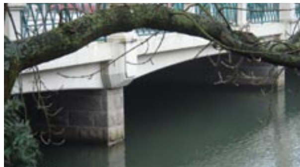
Fig 8.47 Brofundament klätt med beklädnadsgranit med bakstöd av betong.
