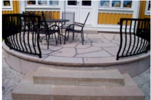
Fig 7.5 Blocksteg av röd, lågerhuggen kalksten leder upp till uteplats med grovhyvlad kalksten i polygonmönster.
