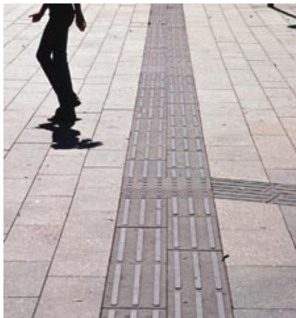
Fig 1.9 Torgyta med taktil markering för vägledning för synsvaga.
