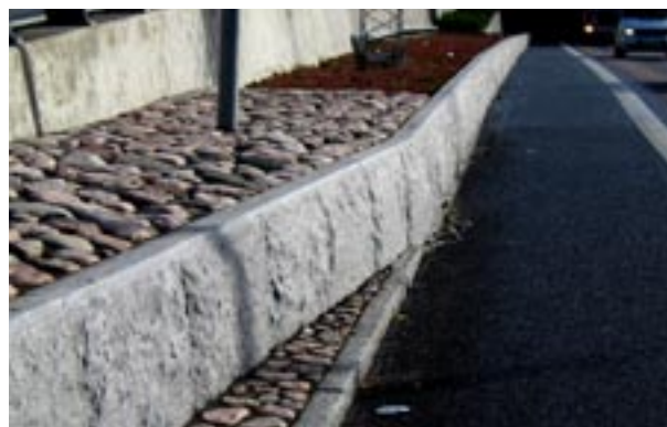
Fig 8.48 Blockstensmur av granit som stödmur och trafikbarriär
