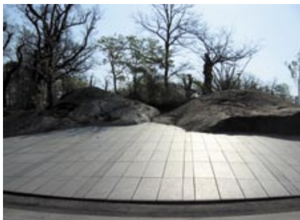
Fig 8.43 Släntbeklädnad av granitplattor i parkmiljö.
