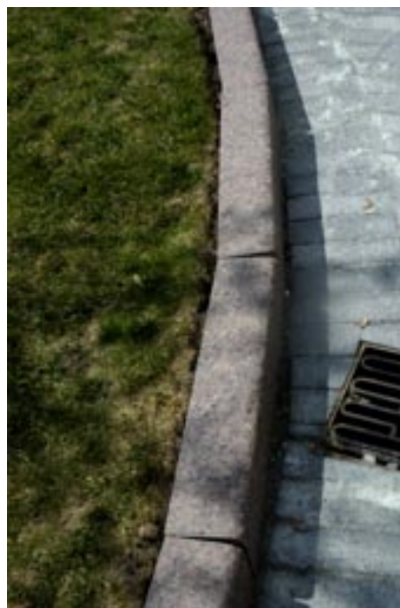
Fig 6.21 Vid montering av rak kantsten i snäv radie blir fogarna kilformade och intrycket av anläggningen förstörs.
