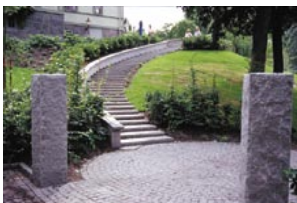
Fig 10.4 Grindstolpar av råkilad granit.
