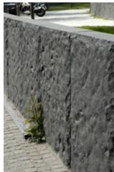
Fig 2.3 Leverans av polygonmur, tv, och blockmur, th, från fjärran land. Utseendet är inte vad beställaren hade förväntat sig, trots att stenen uppfyller alla krav enligt beskrivningen. Stenarna i polygonmönstret har en alltför jämn och enhetlig storlek. Ytbearbetningen ger i båda exemplen ett naturligt intryck.
