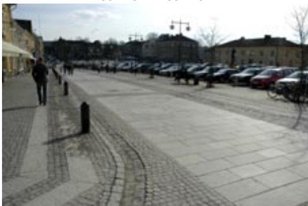
Fig 4.24 Gårdsgata med beläggning av granithällar och smågatsten
