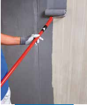
Applicering av Eco Prim Grip Plus på betong med roller
