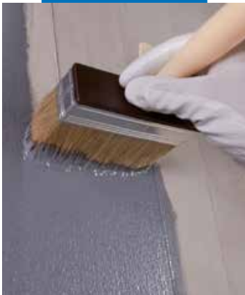
Applicering av Eco Prim Grip Plus på betong med borste
