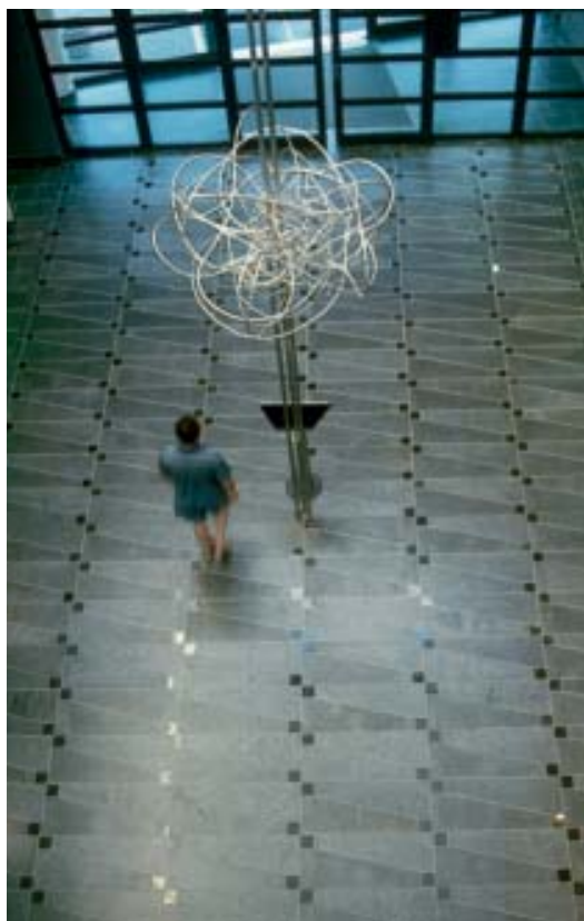
Fig 4.58 Golv av slipad skiffer, med speglande inläggningar av polerad, svart diabas, väcker besökarens intresse.
