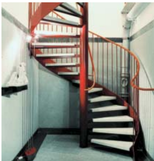
Fig 5.19 Stålkonstruktion med marmorsteg. Plattstål på högkant mellan mittspindel och vangstycket är infällda i stegens undersidor och bär dessa.
