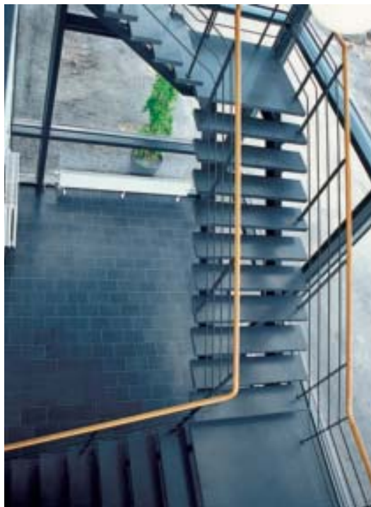
Fig 5.22 Trappa med fribärande steg på stålkonstruktion.
