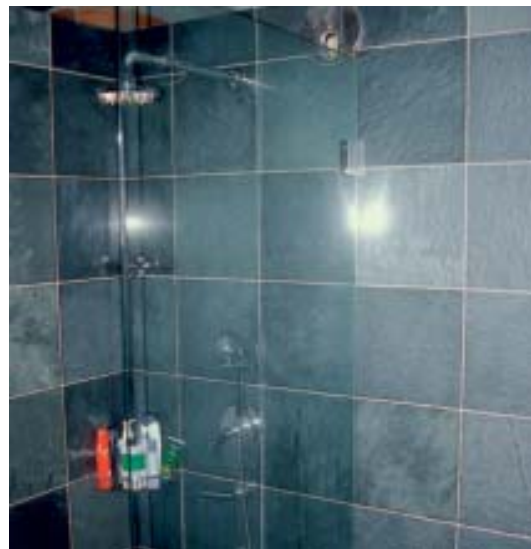
Fig 7.3. Polerade plattor av skiffer på vägg i duschrum.
