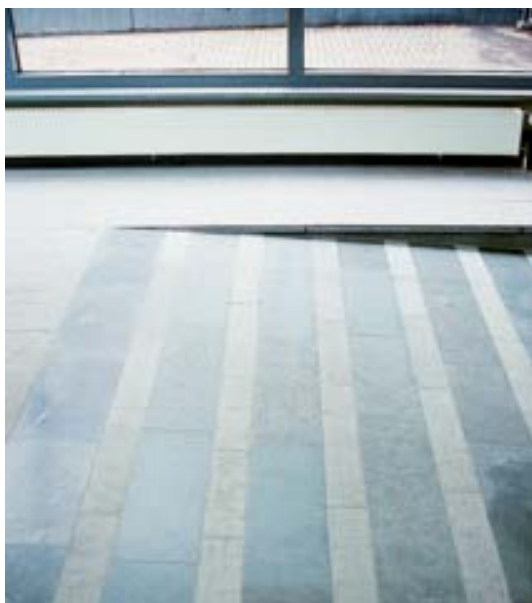
Fig 4.45 Lutande ramp av kalksten i kontorsentré. Lågerhuggna band utgör halkskydd och visuell markering.
