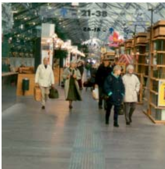
Fig 4.48 Plattor med avvikande kulör och med frästa spår inlagda för att vägleda synsvaga är samtidigt ett dekorativt inslag i miljön.
