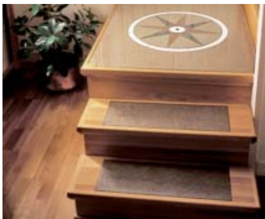
Fig 5.28 Trätrappa med kalksten infälld.
