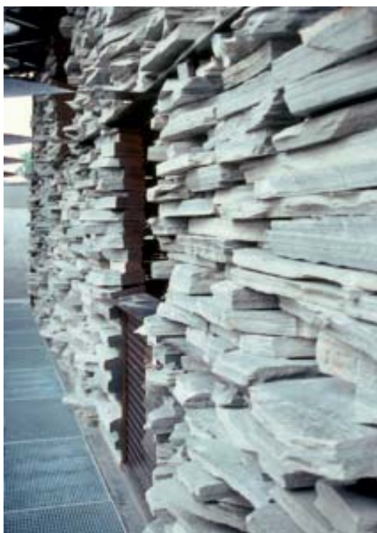
Fig 6.18 Glest staplad tormur av skiffer på bärverk av stål ger speciell effekt.
